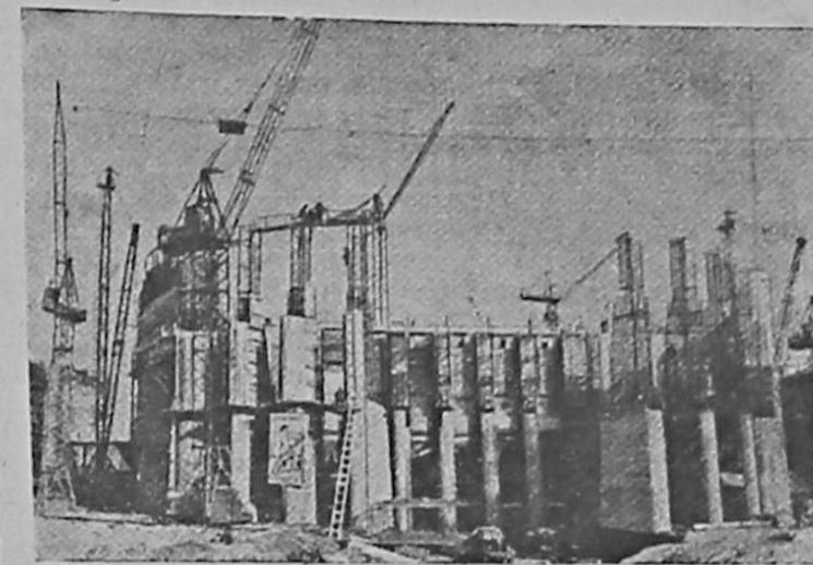
Куйбышевгидрострой. Скоро вступит в строй первый пусковой объект Куйбышевского гидроузла — нижние судоходные шлюзы. День и ночь на громадной территории шлюзов кипит работа. На снимке: монтажные работы на пирсах верхних головных сооружений двухкамерных судоходных шлюзов.
